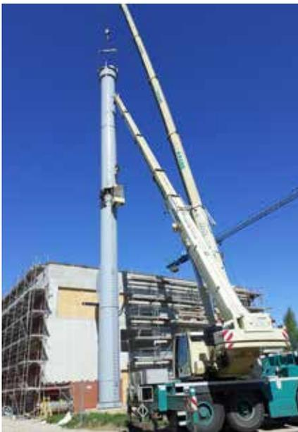
Abb.: Der zweizügige Kamin für die BHKW „Süd“ (Inbetriebnahme 08/2020) und „Sonne“ (Inbetriebnahme zusammen mit der Solarthermieanlage und dem Wärmespeicher Ende 2021) wird an der Westseite des iBHKW-Gebäudes aufgestellt.
