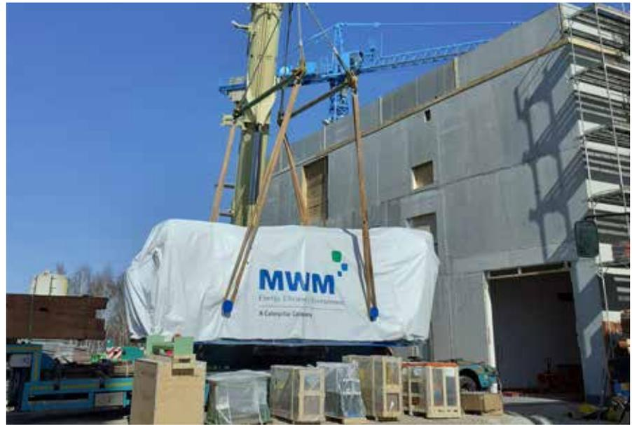
Abb. oben: Der neue Gasmotor „TCG 2032 V16“ aus den Motorenwerken Mannheim wird auf dem Gelände des Heizkraftwerkes abgeladen.
