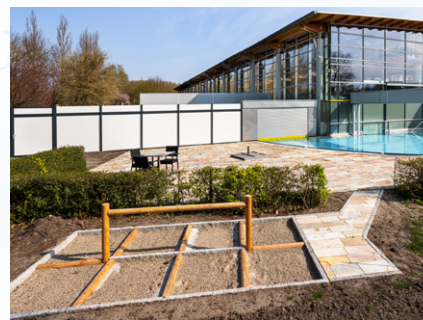
Abb.: Der Fußreflexzonen-Parcours wurde während der Schließzeit des Bades angelegt.
