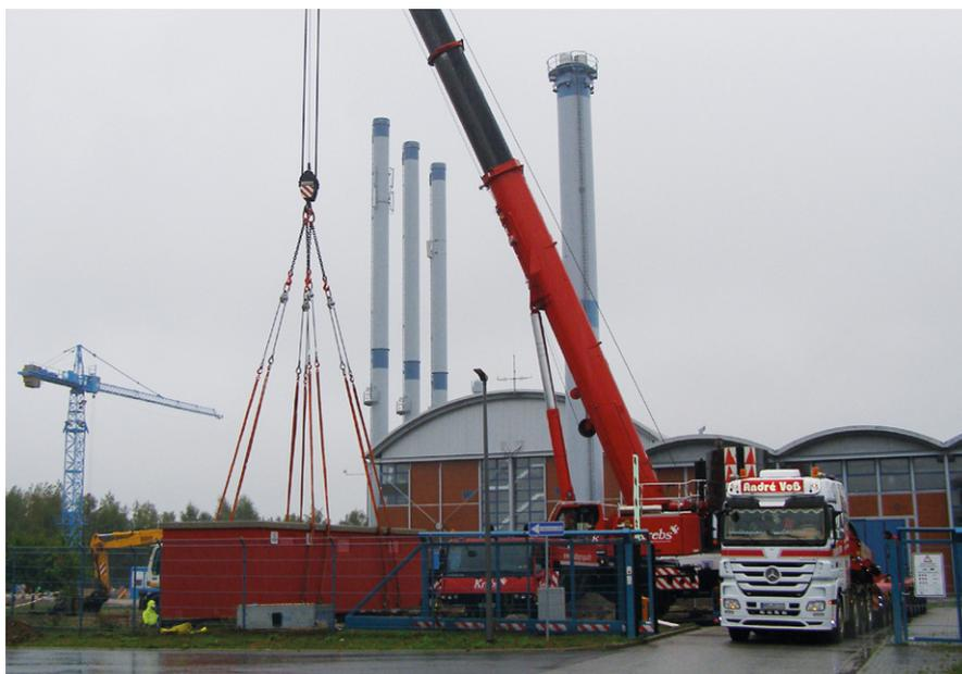
Abb.: Schaltstation „Zenit“ wird im Ganzen abgestellt
