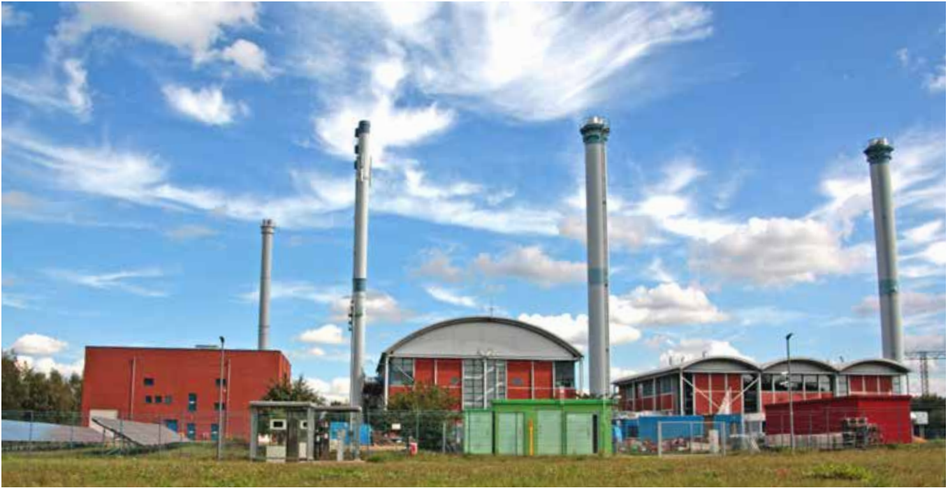
Abb.: Anlagen der Greifswalder Wärmeerzeugung im Gewerbegebiet Am Helmshäger Berg
