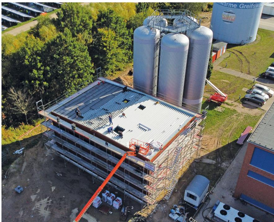
Abb.: Auf dem Kraftwerksgelände entsteht ein neues Betriebsgebäude. Hier wird die Anlagentechnik eingebaut: zum Beispiel Wärmetauscher, Pumpen und Armaturen für den Betrieb des Wärmespeichers und die Abnahme der Solarthermiewärme.
