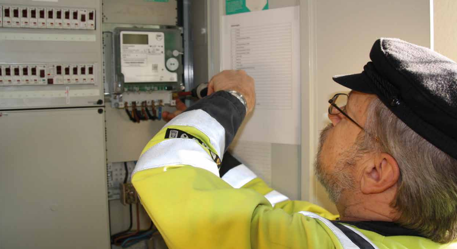
Abb.: Thomas Hall, Monteur bei den Stadtwerken, wechselt den alten Stromzähler gegen eine digitale Messeinrichtung.
