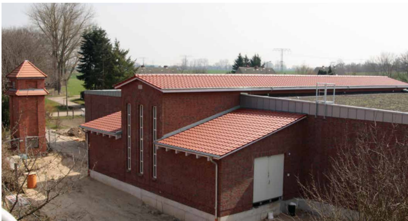
Abb.: Der neue Trinkwasserspeicher neben dem Wasserwerk in Groß Schönwalde
