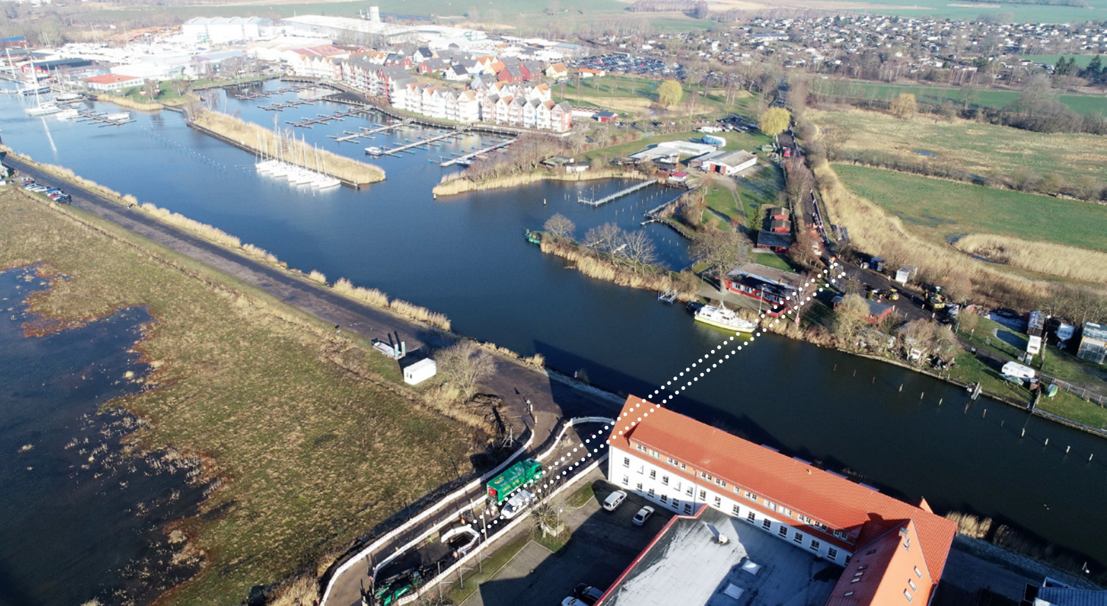
Abb.: Geplanter Leitungsverlauf unter dem Ryck; Foto: Beermann Bohrtechnik
